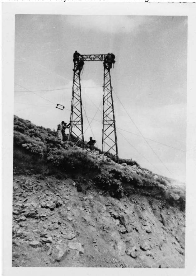
Pour les poteaux métalliques, qui mesureraient dix mètres, chaque pied nécessitait au minimum un trou d'un mètre au carré, et d'un mètre dix de profondeur, qu'il fallait remplir de béton. Là encore, le béton était pétri pelle en main, sans bétonnière, ni toupie. Une fois l'installation terminée, il fallait étaler deux couches de peinture, au pinceau, toujours à la main. Pas sûr qu'un harnais de sécurité soit utilisé. Venait ensuite l'équipement des poulies, puis des « tasses ».
